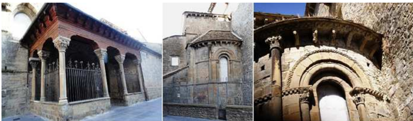
❶ Pórtico renacentista con tres y dos arcos sobre un murete. ❷ Sobre su fachada se localizan los elementos característicos del Camino de Santiago. Y que se difundirán por el mismo, como son los ajedrezados y los canecillos. ❸ Ventana del ábside de la Epístola.
