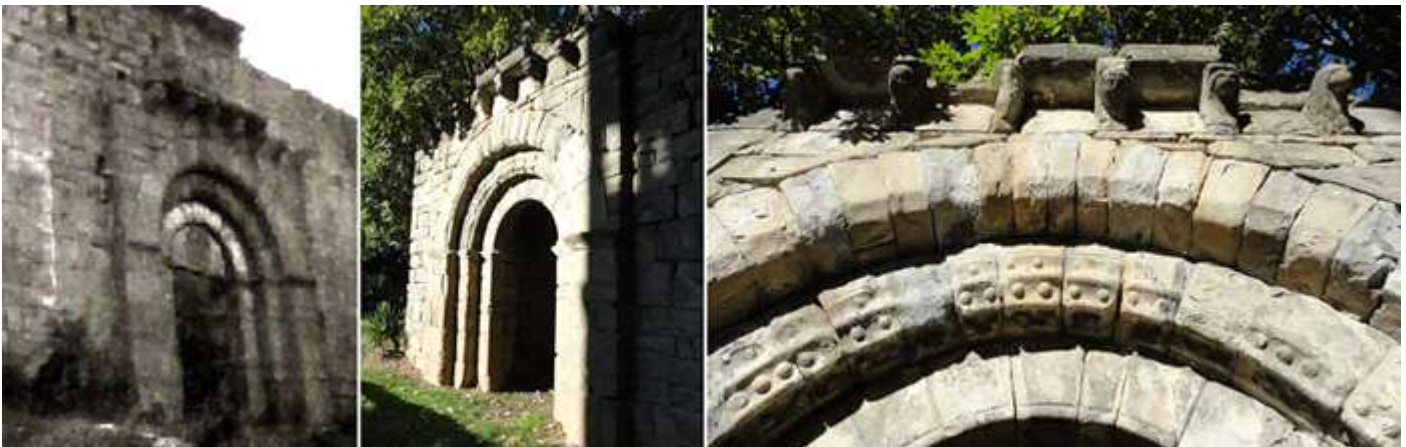
❶ Foto retrospectiva, tomada del cartel informativo con su tímpano en la puerta. Que al ser abandonado en la década de los /o del siglo pasado se trasladó para su conservación. ❷ La portada adelantada y con un tejeroz con ocho canecillos. ❸ Las tres arquivoltas de las cuales son lisas las exteriores y la central con un perfil y decorado a bolas a sus lados y en la parte interior. Y que apean en impostas corridas con decoración de figurillas y palmetas. Esta portada sería posterior al resto sobre el S. XII.
