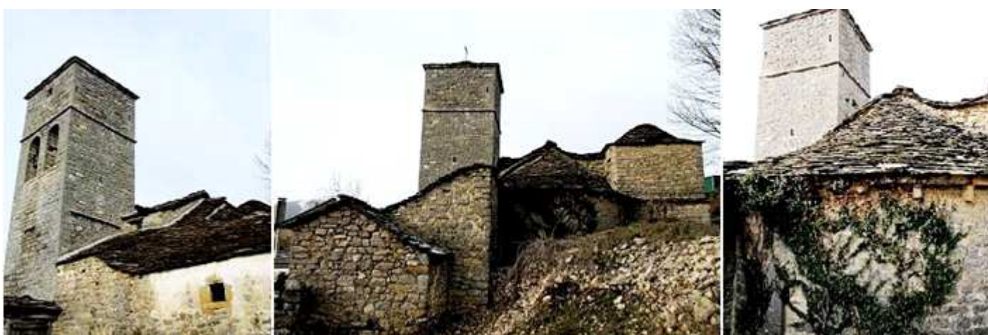
❶ Su torre de tres cuerpos separados por impostas. ❷ Cabecera con algunas construcciones adosadas. ❸ Un tramo de la misma con un alero con canecillos lisos y una cubierta con lajas de piedra.
