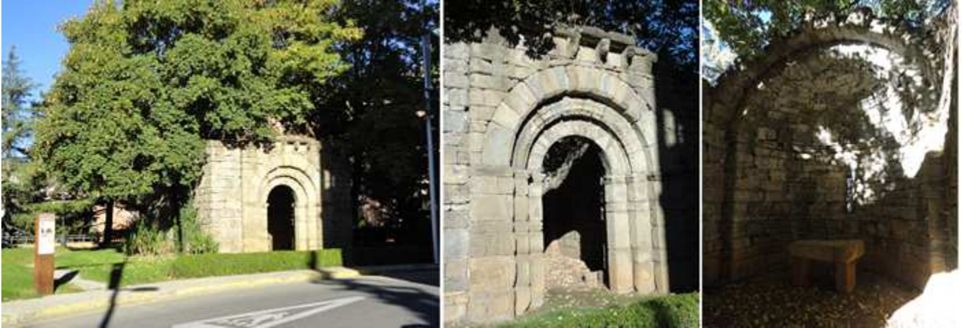
❶ En esta zona ajardinada se reconstruyó el templo. ❷ Con una portada de medio punto. ❸ Ábside y arco triunfal.
