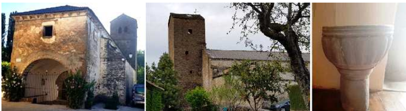
1 Iglesia con planta rectangular y su puerta alojada dentro de un pórtico de medio punto con dovelas lisas. 2 Torre de planta cuadrada adosada a su cabecera fue construida en el S. XVIII. 3 Pila de piedra con taza semiesférica con un borde bocelado y debajo con gallones con gran relieve con un fuste redondo encastrado en el suelo, se encuentra junto a la puerta de entrada del templo. Fotos: Antonio Rabal.
