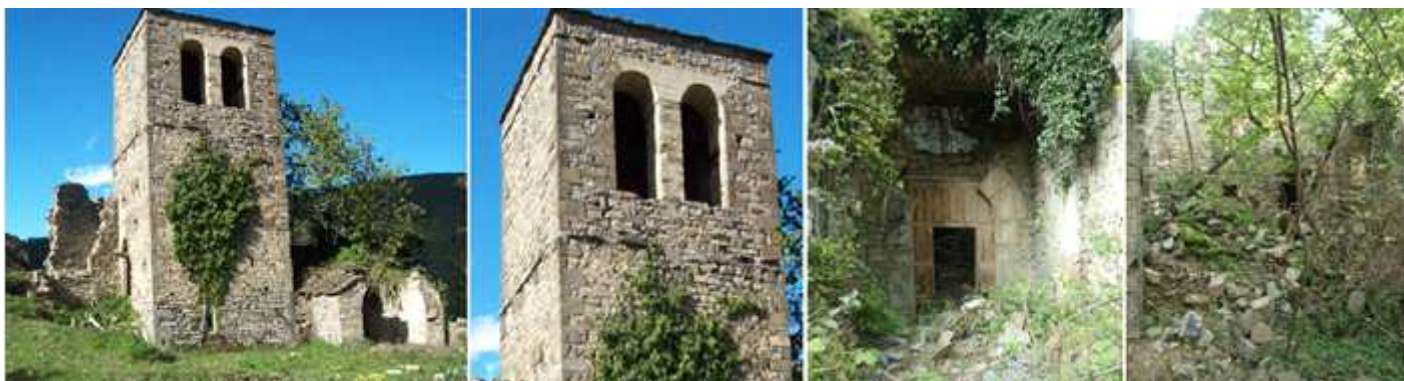
❶ La torre es El campanario está abierto por dos grandes ventanales de medio punto. ❷ La vegetación cubre el pórtico de entrada y su puerta. ❸ Y la parte interior del templo. Fotos: Marta Puyol Ibort (SIPCA – www.sipca.es )
