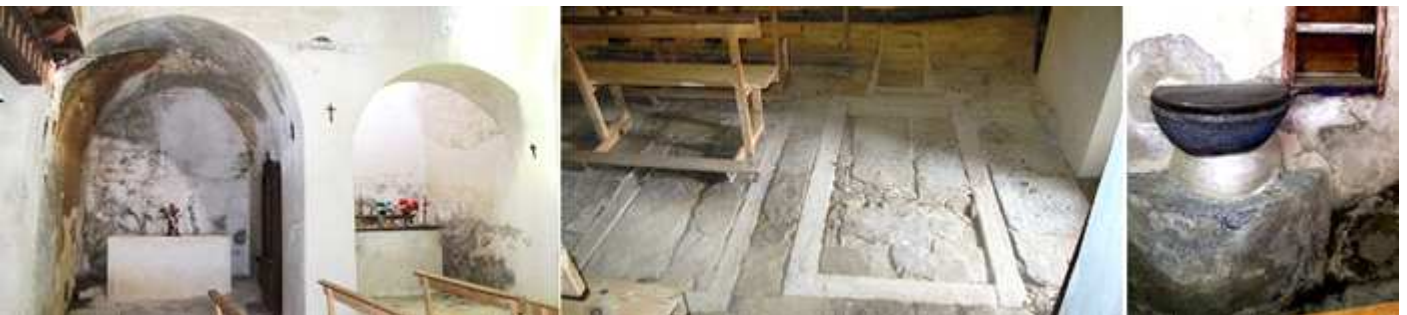
❶ Dos de las capillas alojadas en arcos de medio punto de distinto tamaño en el lado del Evangelio. ❷ Diversos enterramientos en el interior del templo. ❸ Pila bautismal de piedra con restos de policromía de taza semicircular sobre un poyo de obra con un tape de madera abatible, alojada en una de las capillas laterales.
