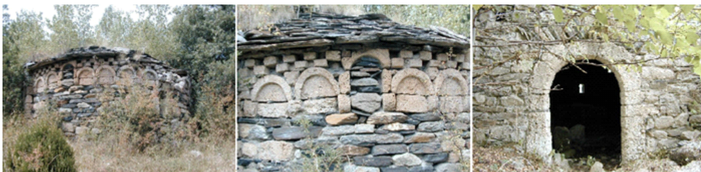
❶ Su ábside con los arquivoltas lombardos. ❷ Arquivoltas ciegas talladas en la piedra, es la parte más destacada del templo. ❸ A los pies dispone de su entrada con un arco de medio punto con dovelas de tosca. Fotos: Marta Puyol Ibort (SIPCA – www.sipca.es )
