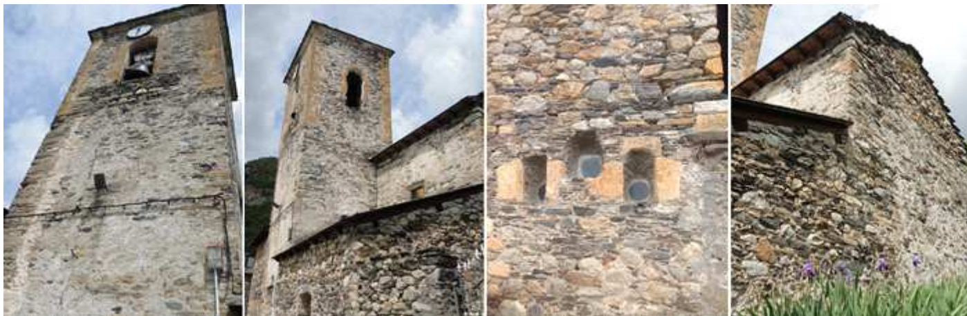
❶ Su torre de planta cuadrada de tres cuerpos, en uno de los lados del campanario cuenta con un reloj. ❷ Su campanario abierto con ventanas de medio punto en cada una de sus caras. ❸ Lateral con unas aberturas que iluminan el templo. ❹ Su ábside recto con la sacristía adosada a este lado.
