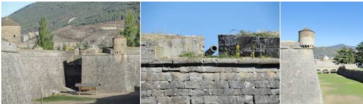
❶ Detalle del espacio que se producía con los baluartes que se separan del perímetro pentagonal. ❷ Uno de los cañones alojados en una tronera. ❸ Perspectiva de la anchura del foso que recorre toda la ciudadela. Donde suelen pastar algunos ciervos.
