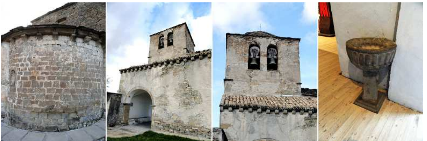
❶ Detalle de la parte libre del ábside. ❷ Lateral del medio día. ❸ Sobre la parte baja del templo se alza la torre campanario abierta con dos ventanas. ❹ Pila de agua bendita con su exterior una banda ente el borde y bocel con gallones en relieve como los baquetones, su fuste es una piedra tosca de sección cuadrada sobre basa de igual formato.
