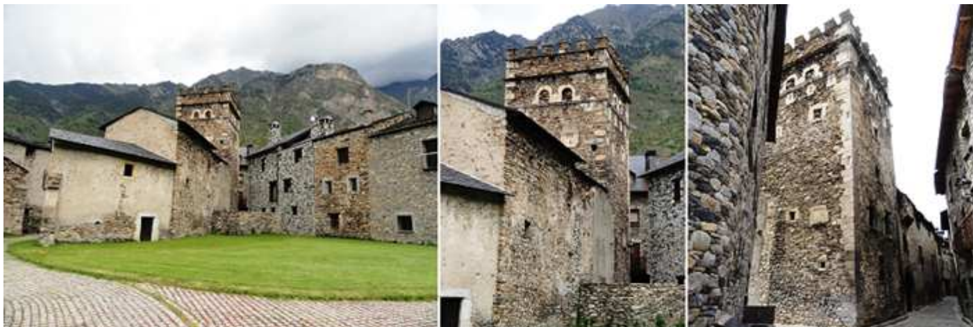
❶ Espacio de la Casa de Juste, ante la avenida de Francia. Fue construida a mediados del S. XVI. ❷ En esta construcción posee una torre de planta rectangular con 17 m de altura como defensa de sus dueños de esta casa palaciega. ❸ Construida con cantería irregular y piedra sillar para sus ángulos y ventanas.
