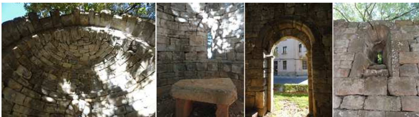
❶ Cascarón del ábside. ❷ Detalle de la cabecera con la mesa de altar y una ventana con derrame interior. ❸ El arco de la puerta desde el interior del templo. ❹ Ventana del lado epistolar.
