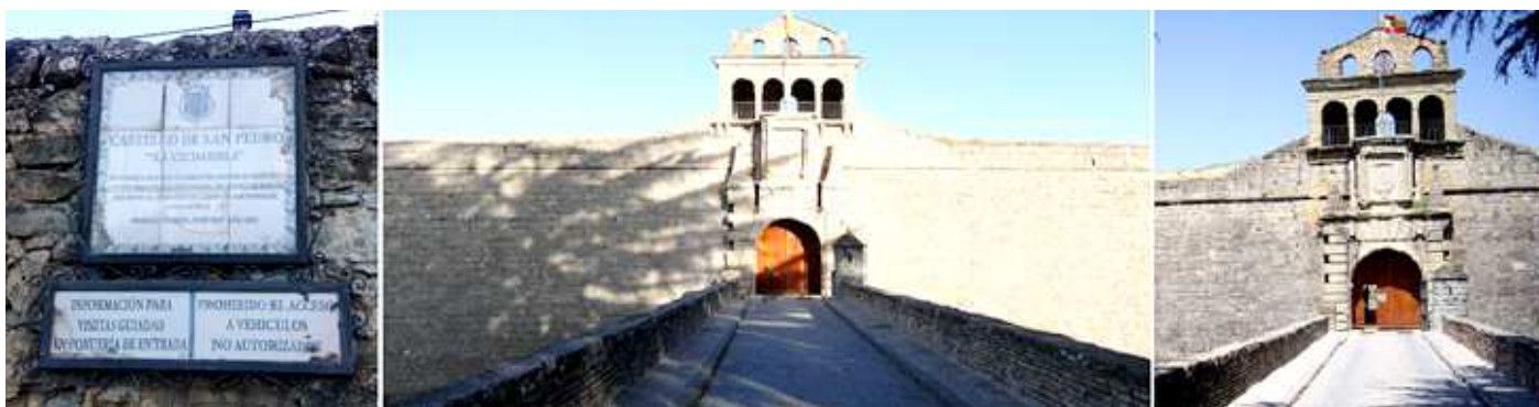
❶ Premio Europa Nostra 1985. ❷ Puente con tres arcos que salva el foso ante su puerta. ❸ Sobre su puerta adelantada y almohadillada, dispone el escudo de los Austrias sobre su entablamento, y sobre la misma una galería de arcos con una espadaña.
