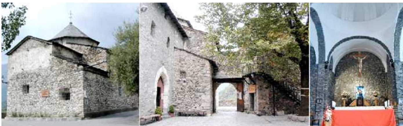
❶ Cabecera y lateral norte. ❷ Lateral sur con la puerta de entrada y al fondo la entrada al santuario por un portalón. ❸ Cabecera recta con un Santo Cristo y la talla de la Virgen, ante ella la cúpula ciega con ocho anchos nervios. Fotos: Marta Puyol Ibort (SIPCA – www.sipca.es )
