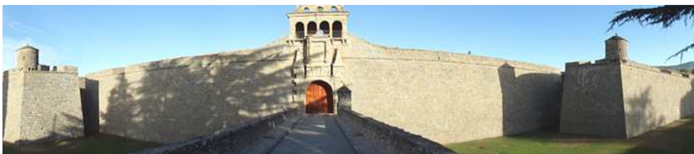
❷ Panorámica de su fachada principal protegida por dos baluartes provistos de garitas circulares.
