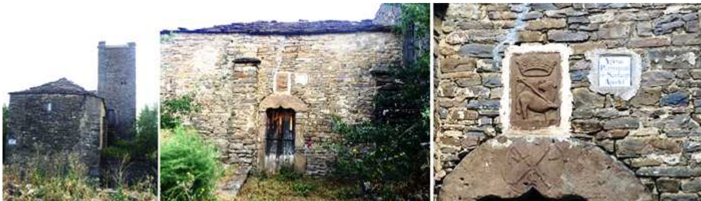
❶ Cabecera del templo con una sencilla ventana de medio punto, y su cubierta a dos aguas con lajas de piedra. ❷ Lado del Evangelio con un contrafuerte y su puerta. ❸ Sobre el dintel de su puerta, con arco de medio punto exterior y conopial en el interior esta su crismón. Y encima la enseña de pertenecer a la abadía de San Juan de la Peña. Fotos: Ángel Javierre.
