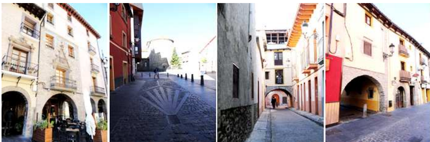
1 Casa con una fachada gótica en la plaza de la Catedral. Sobre el balcón un frontis triangular con dos ángeles que sostienen la ciudad. 2 Parte posterior de la catedral con la señalización del Camino de Santiago en su empedrado de la Plaza de la Ripa. 3 Calle del Arco. Con arcos rebajados a sus dos lados y otro en su interior. 4 Boca del Arco con la calle San Nicolás, nº 4.
