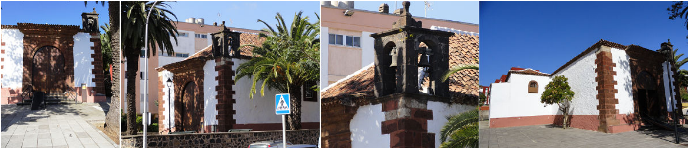
1 - 2 - 3 - 4 Diferentes elementos constructivos del templo de San Juan Bautista.
