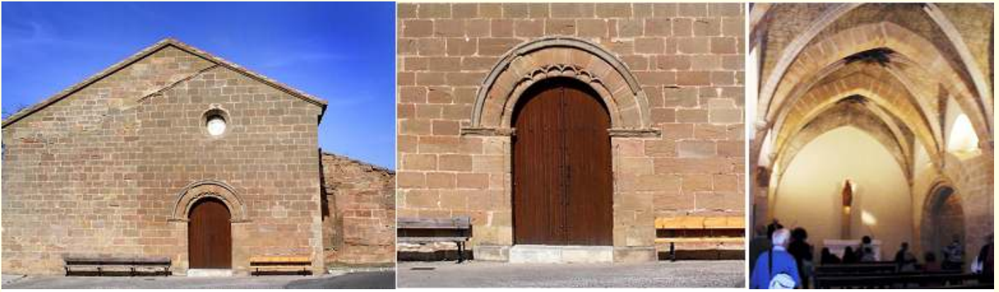
❶ Fachada de la Ermita del Pilar. ❷ Portada de pedio punto con sus arquillos en la parte interior (los que quedan). ❸ Interior de la nave con sus arcos fajones apuntado arrancando desde ménsulas decoradas.
